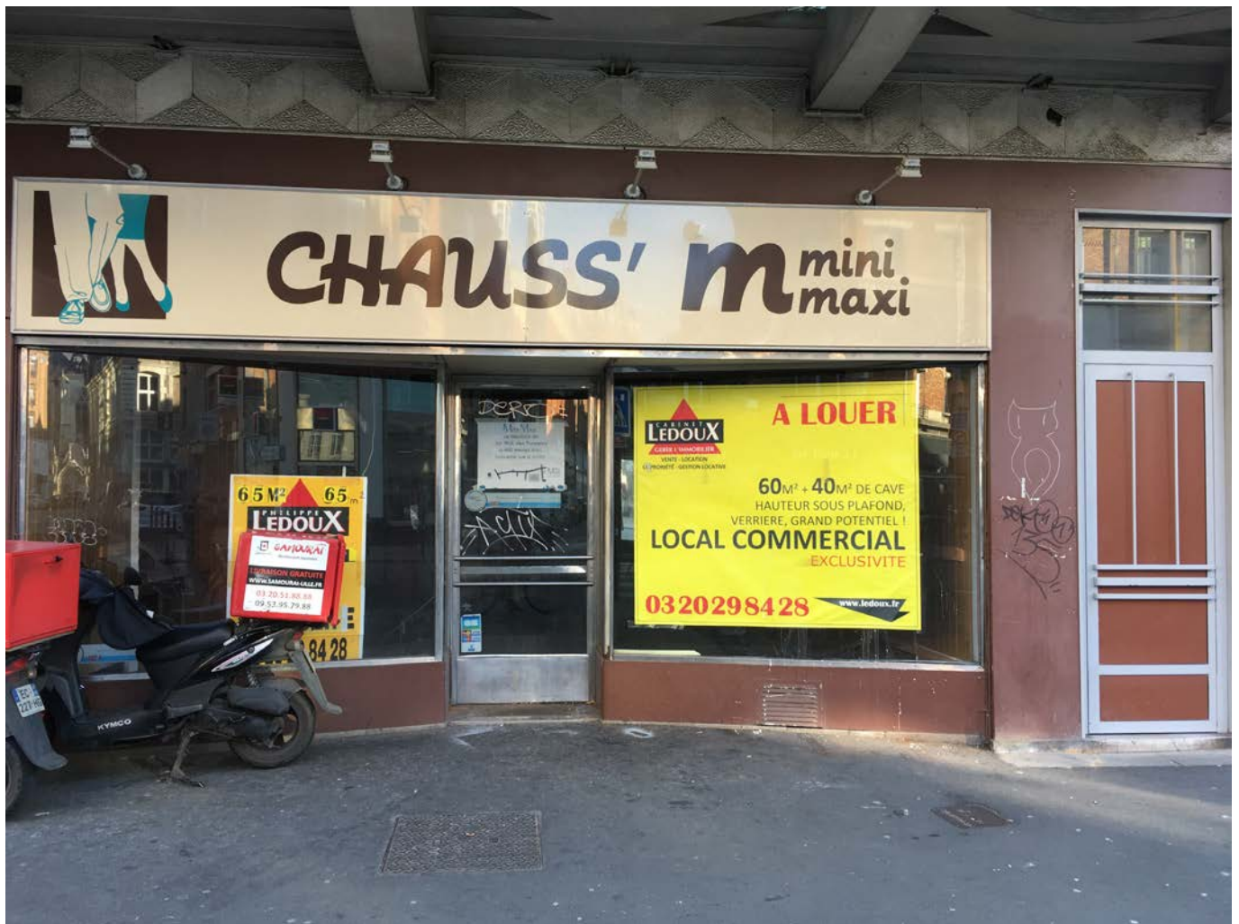
Local commercial sur la rue Molinel en 2018, vacant depuis au moins 5 ans ©MEL
