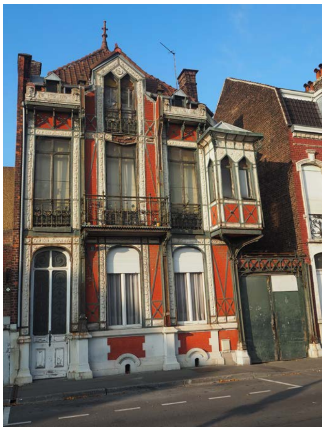
Maison vacante à Roubaix ©SPLA La fabrique des quartiers : dispositif de recyclage de l'habitat vacant dégradé (2017-2019)
