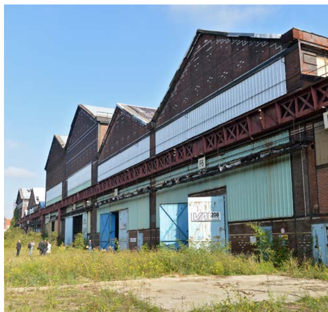
Halles agrégées sur le site de Fives Cail-Babcock en 2013 ©MEL
