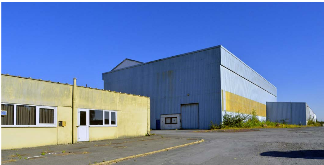
Locaux d'activités vacants sur la friche Malbranque à Illies en 2016 ©MEL
