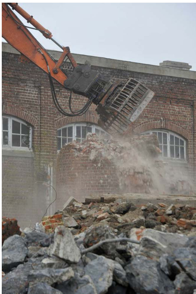
Démolition du bâti sur la friche Brevart ©MEL
