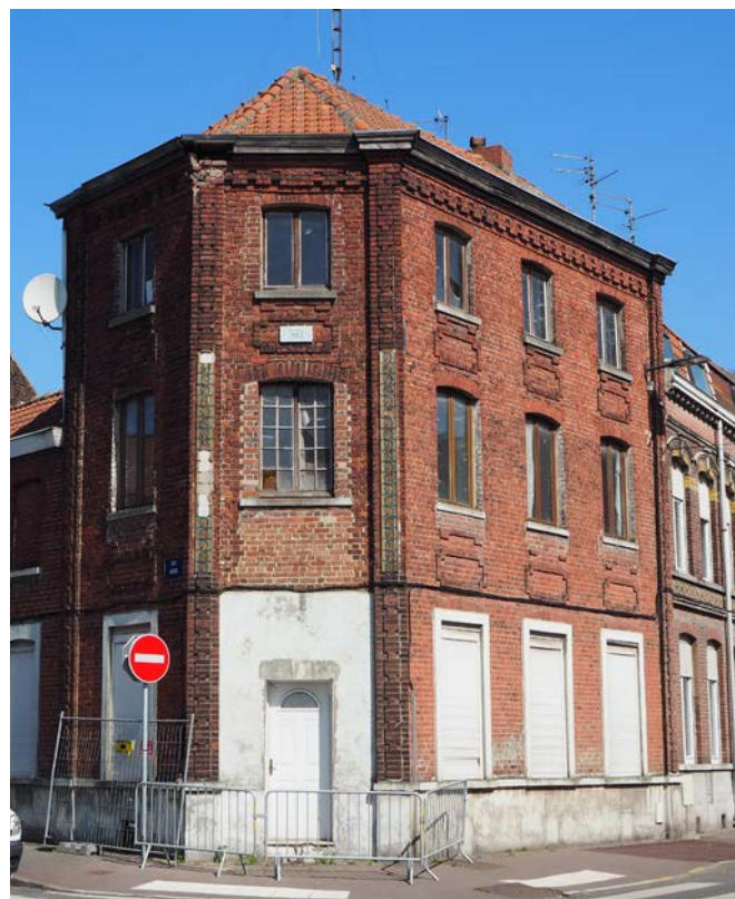
Maison vacante à Tourcoing ©SPLA La fabrique des quartiers : Dispositif de recyclage de l'habitat vacant dégradé (2017-2019)
