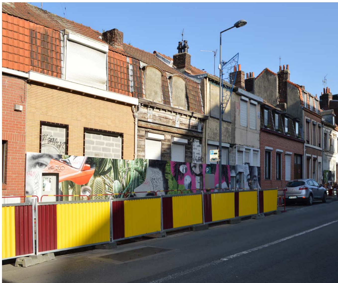
Maisons vacants sur la rue de faubourg de Roubaix depuis au moins 3 ans, suite à l'expropriation en préparation de l'opération d'aménagement Pépinières à Lille
