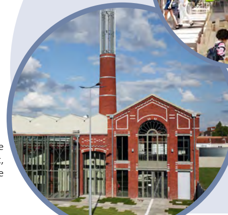
Ville collaborative Maison Poc Chaufferie Huet, la Madeleine
