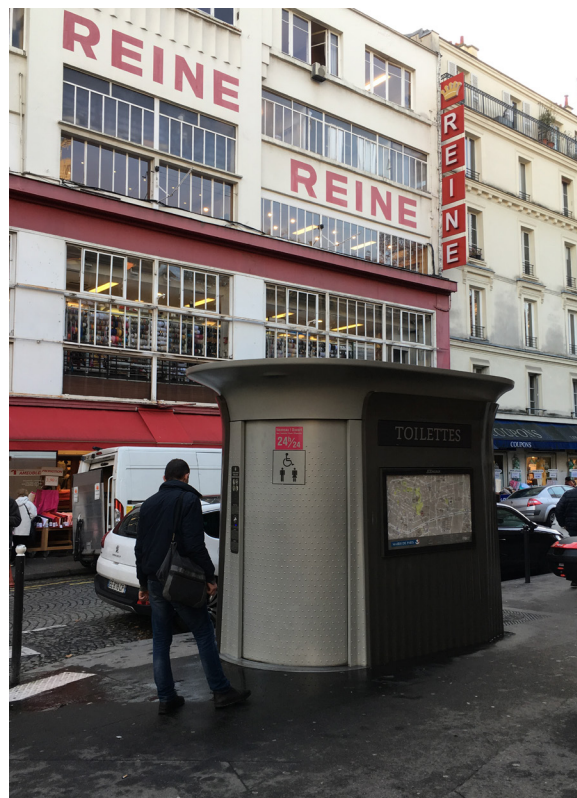
Toilettes automatiques JC Decaux (Paris 18 e )
