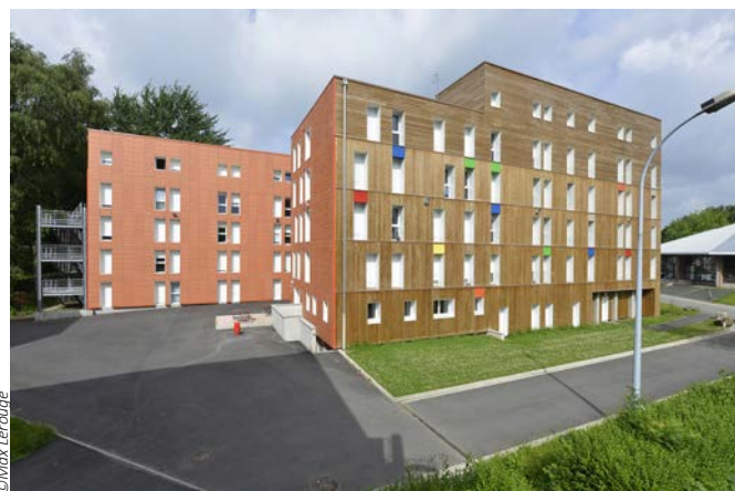
Résidence Albert Camus rénovée (Crous), Villeneuve d'Ascq ©Max Lerouge
