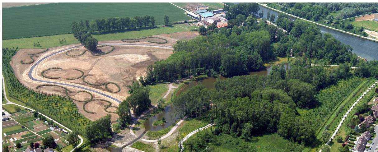
Parc de la Deûle : le jardin Mosaïc en cours d'aménagement
