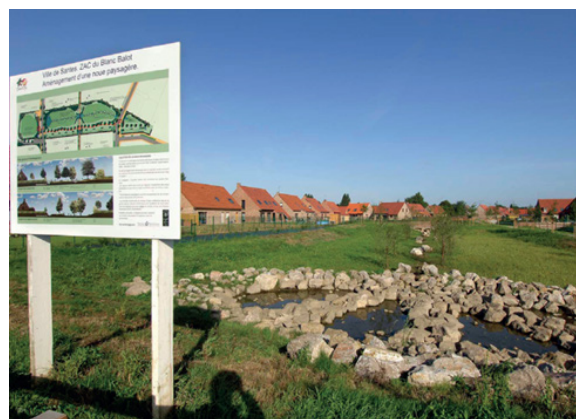
ZAC à Santes, gestion alternative des eaux de pluie
