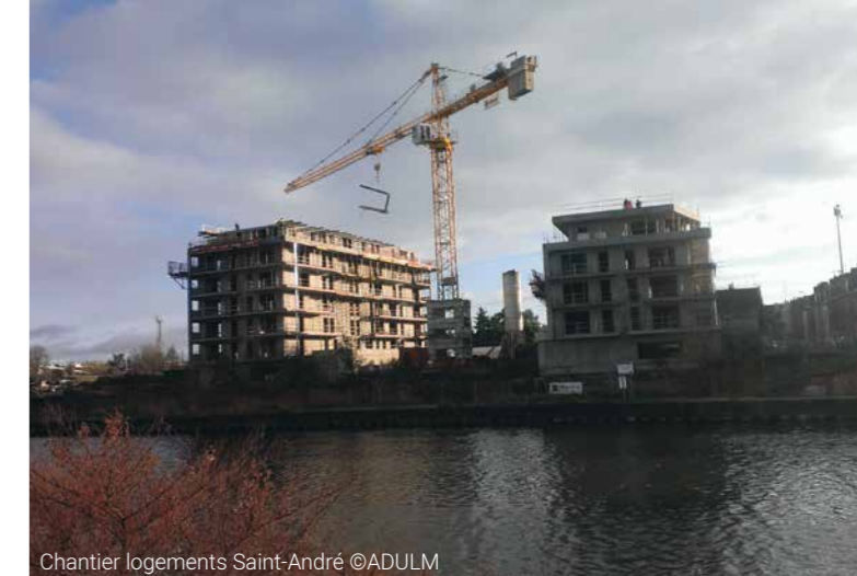
Chantier logements Saint-André ©ADULM
