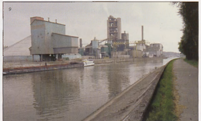
Cimenterie à Antoing (Escaut).
