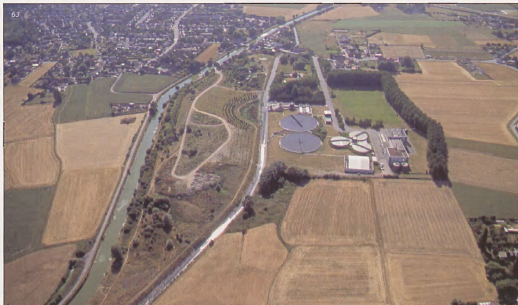
Waterzuiveringsstation te Wattlelos - Station d'épuration à Wattlelos.
