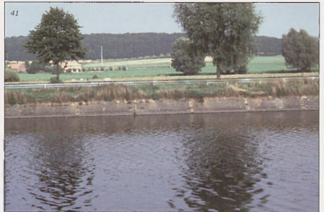
Betonnen oevers langs het Kanaal Kortrijk-Bossuit te Zwevegem.
