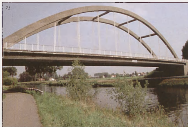
Le Pont de Pottes sur l'Escaut.
