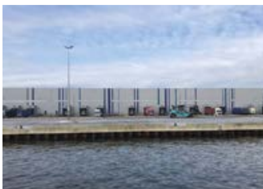
La Deûle infrastructure : entrepôt de Roquette au Port de Santes
