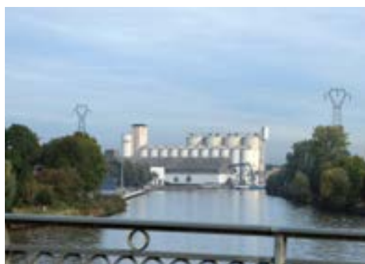
La Deûle bâtie, singulière : silo d'InVivo au Port de Santes
