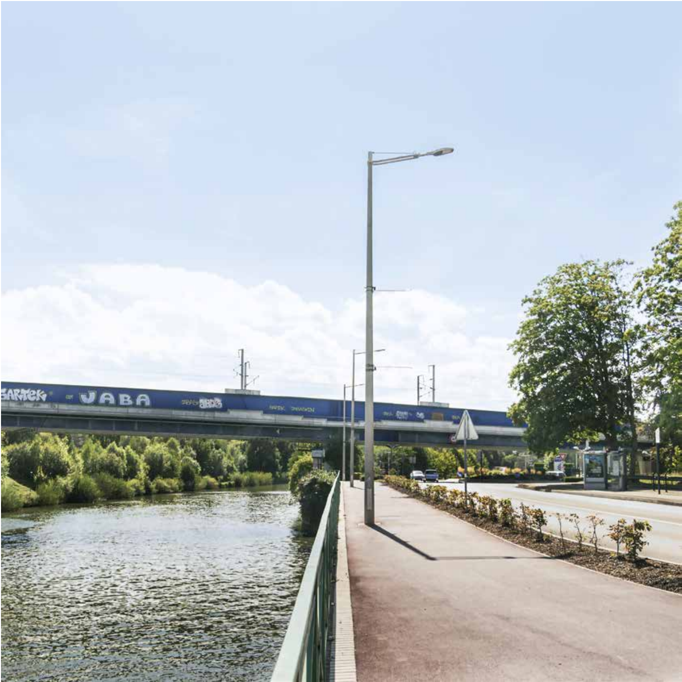
2021 | LE PONT DE CHEMIN DE FER DEPUIS LA RUE DE LILLE
